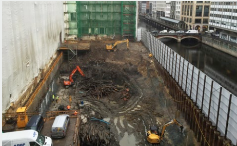
Anspruchsvoller Aushub am Alten Wall
