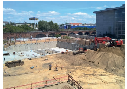
KPP foundation for „Max und Moritz“
