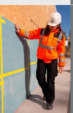
Für eine wirksame Dämmung der Schwingungsimmissionen ist eine lückenlose Verlegung der Dämmmatten erforderlich. Während der Bauausführung sollte eine Kontrolle durch eine baudynamisch geschulte Fachkraft erfolgen.
