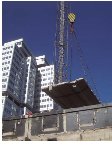
Krangeführter Rückbau beim Bauvorhaben DRV-Rechenzentrum.
