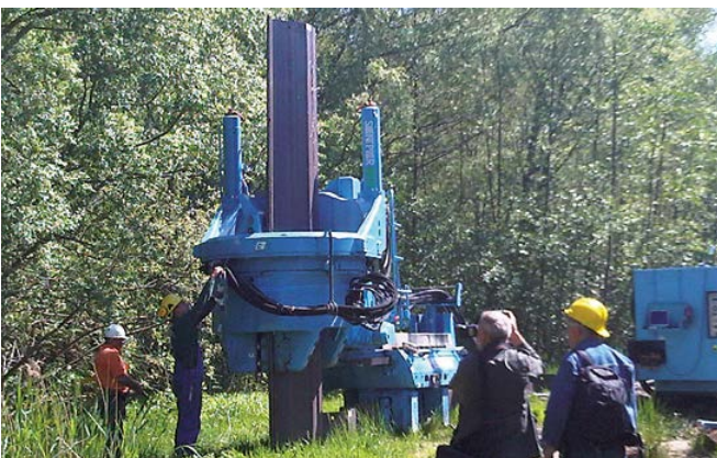
Herstellung der Abstomsicherung (Spundwand) in Rostock.
