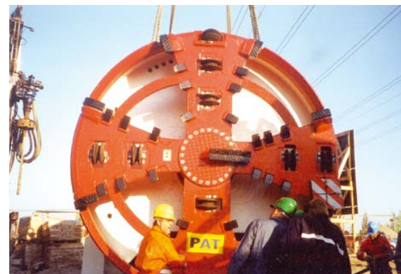
Tunnelbohr- maschine für die Abwasserdruck- leitung Biesdorf- Waßmansdorf, Berlin
