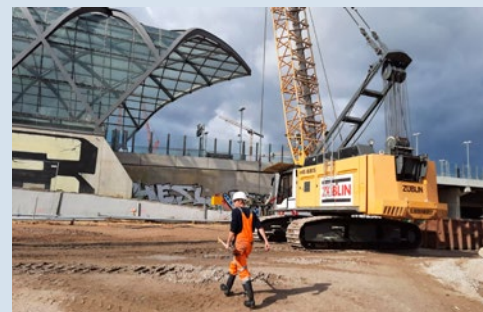
Schlitzwandherstellung für den Elbtower Hamburg direkt neben dem S-Bahnhof.
