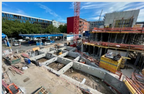
Unter dem Neubau in der Ritterstr. verläuft die U-Bahn.
