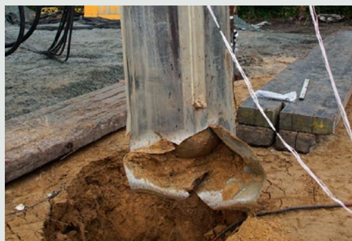
Fußbereich eines Probepfahls nach dem Ziehvorgang.
