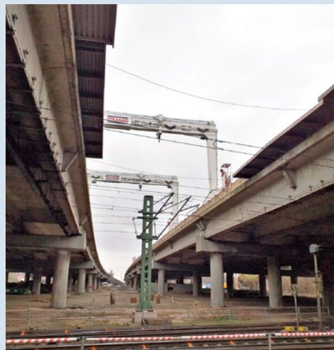
Beide Brücken werden um eine Fahrbahn verbreitert.
