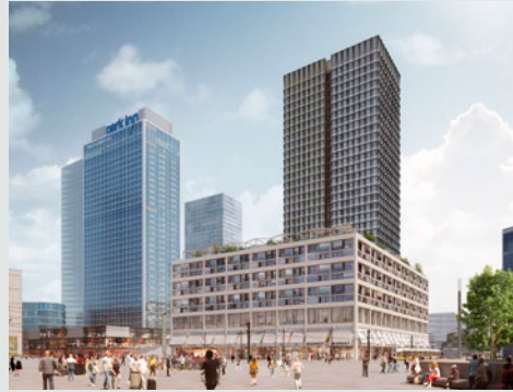
Das neue Hochhaus auf dem Bau-feld D3 am Alex.
