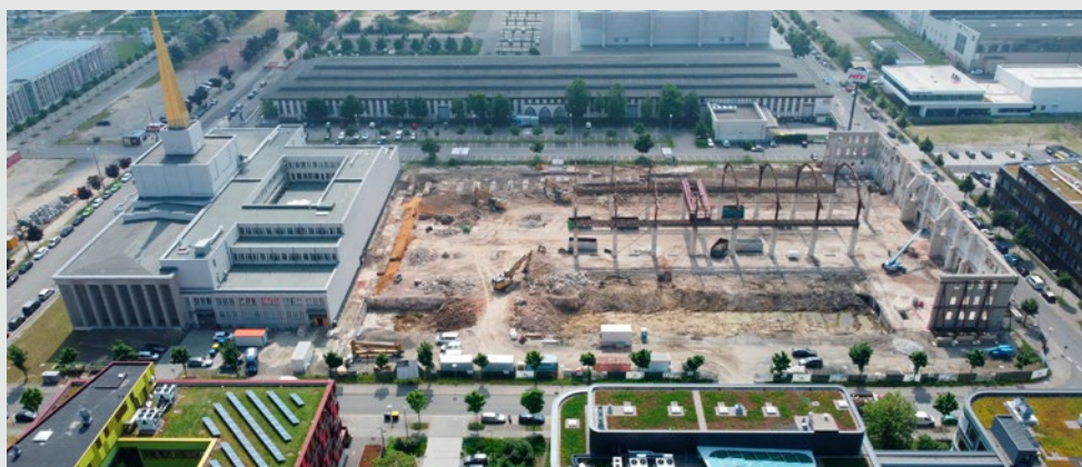
Baugrube unter schwierigen Bedingungen auf dem Gelände der Alten Messe Leipzig.
