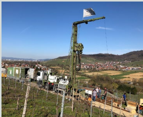
Erkundungsbohrungen bei Schallstadt (Freiburg).
