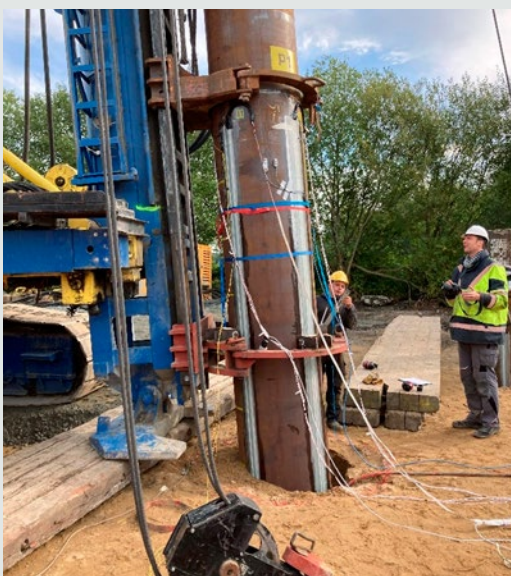
Messungen auf einem Testfeld zur Verifikation des Beulnachweises und -verhaltens großer Monopiles.
