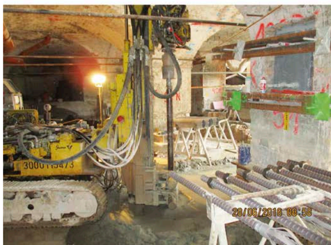
Bild 8. Rückbau der Bodenplatte, Fundamentunterfangungen, Herstellung Mikropfähle Fig. 8. Demolition of the base slab, foundation underpinning, installation of micropiles
