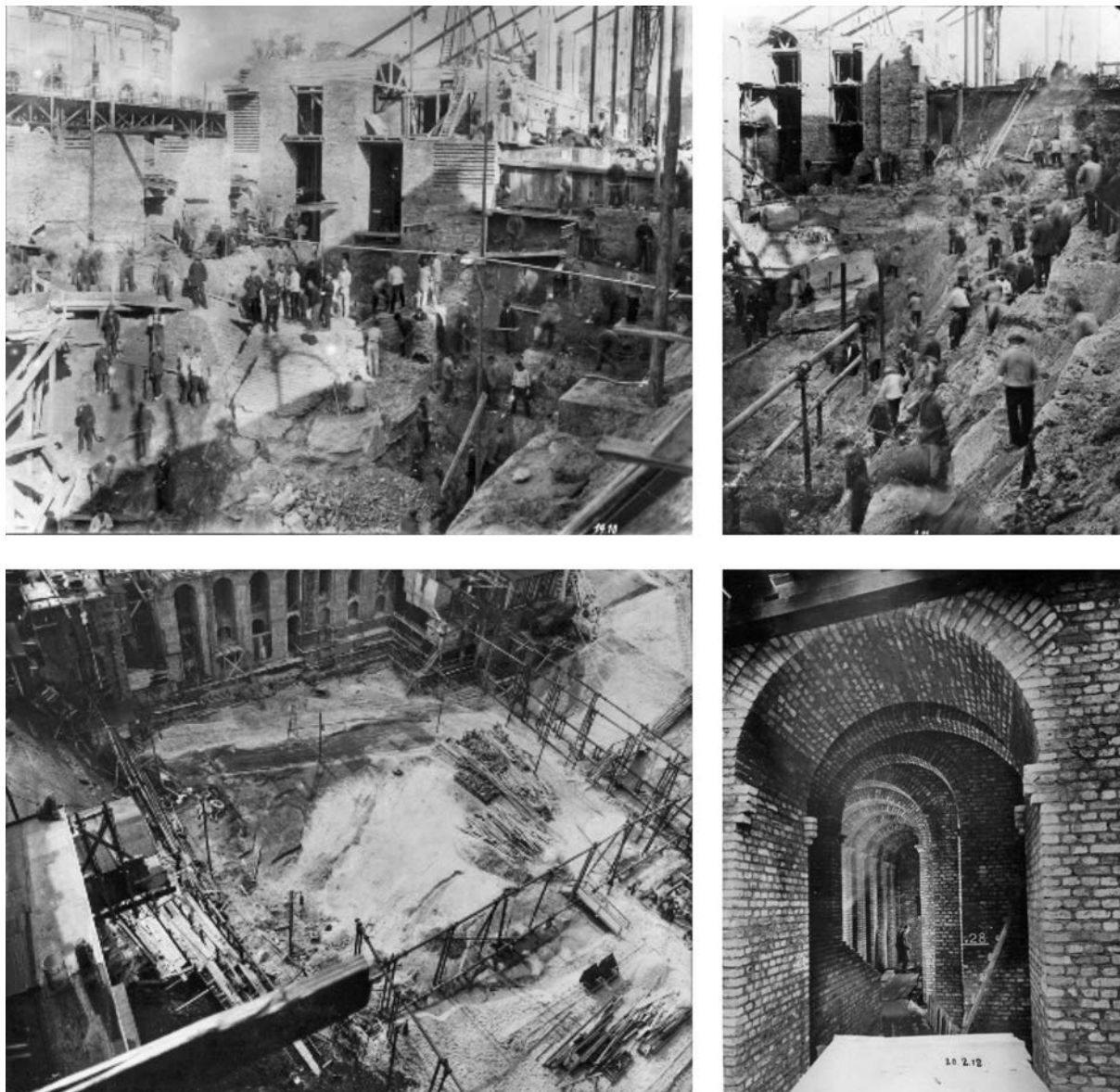
Bild 3. Pergamonmuseum Berlin – Archivfotos: Nordflügel-Tiefkeller; händischer Aushub; Baugrube Südflügel und Forum, Gründungsgewölbe
