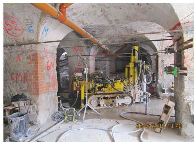
Bild 15. Herstellung der bewehrten Sicherungssohle sowie anschließende Mikropfehlherstellung Fig. 15. Construction of the reinforced support invert and subsequent micropile installation
