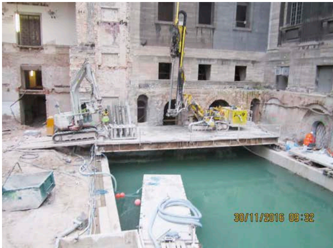
Bild 14. Aushub der Altsubstanz unter Wasser Fig. 14. Excavation of the old substance under water
