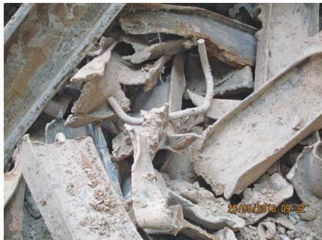
Bild 11. Tiefenberäumung der Hindernisse mit einem Großbohrgerät und geborgene Stahlträger Fig. 11. Deep removal of obstructions with a large drill rig
