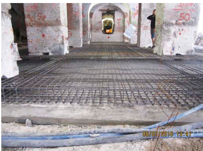
Bild 15. Herstellung der bewehrten Sicherungssohle sowie anschließende Mikropfehlherstellung Fig. 15. Construction of the reinforced support invert and subsequent micropile installation
